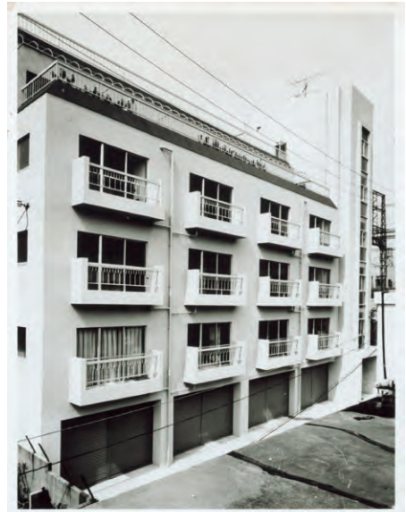
昭和48年10月25日竣工 現 広告美術会館
